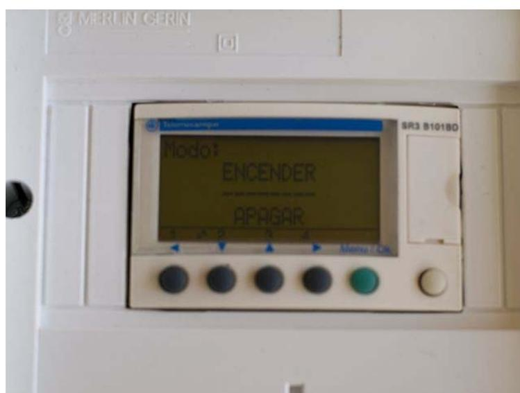
Vista de la pantalla programable indicando que está en la función de “pulsar para encender y pulsar de nuevo para apagar”.
